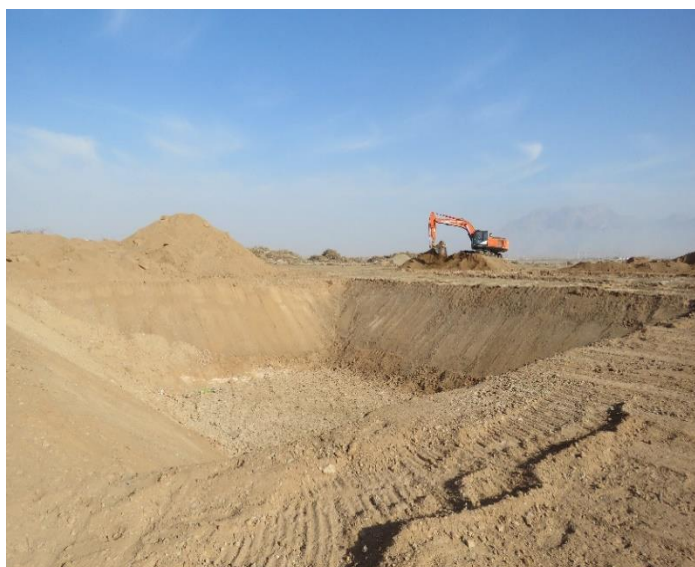
حوضچه‌های شیرابه در حال احداث
