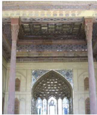
تصویر شماره ۵- قابندی معرق چوب ، عمارت چهل ستون ، صفویان ، اصفهان منبع : زهرشیدی ، ۱۳۸۱ ، ۱۰۹
